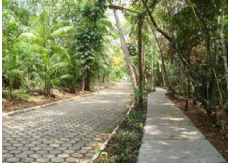
Ejemplo de vial de circulación compartida y mínimo impacto sobre el suelo para acceso a las viviendas en régimen de condominio.
