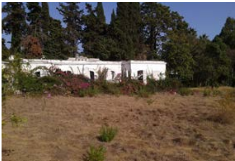
Edificaciones de la antigua vivienda en estado de abandono.
