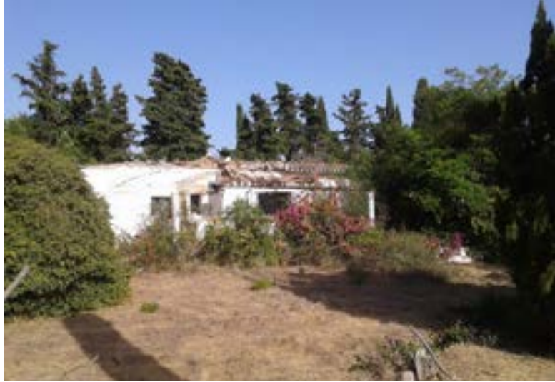
Estado actual de abandono de la antigua vivienda.
