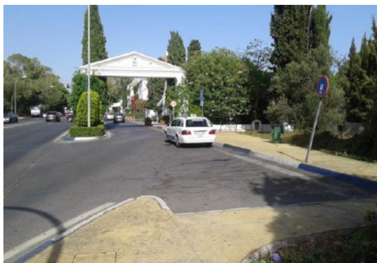
Vial de servicio del bulvar (actuación aislada AA NG 5), parcialmente pendiente de ejecución
