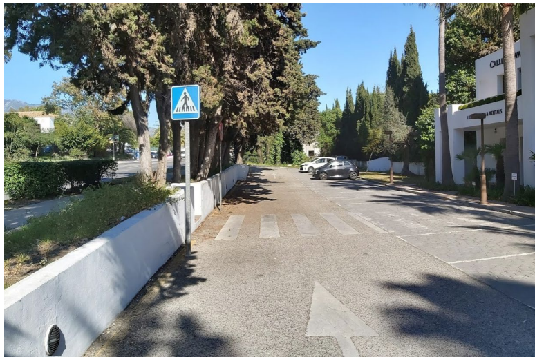
Murete de contención en vial de servicio del ámbito adyacente PA NG 24 "Los Verdiales 2"
