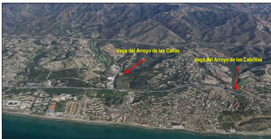
Referencia de vegas fluviales del término municipal de Marbella, degradadas por la ocupación de las edificaciones e infraestructuras
